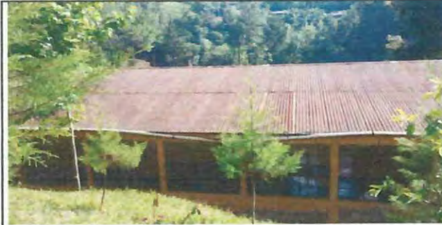
Foto 3: Se cambiarán los canales así mismo se les pondrá su respectiva caída de agua.
