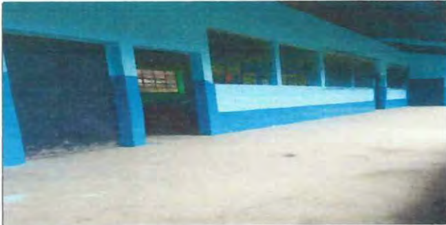
Se instalarán balcones en 12 ventanas
