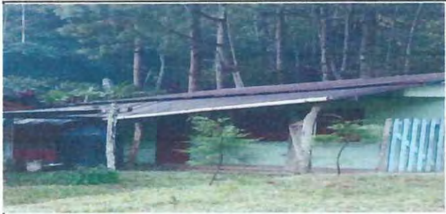
sustitución de cubierta de lámina deteriorada en cocina.
