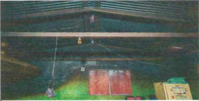
Se instalará estructura de metal y lámina troquelada en techo de la cocina.
