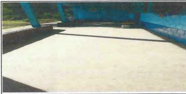
Foto 5: se instalará piso en el corredor
