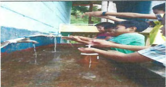
Se sustituirá la instalación de lavado de los niños.
